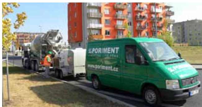
■ PORIMENT® - výrobní technologie na stavbě
